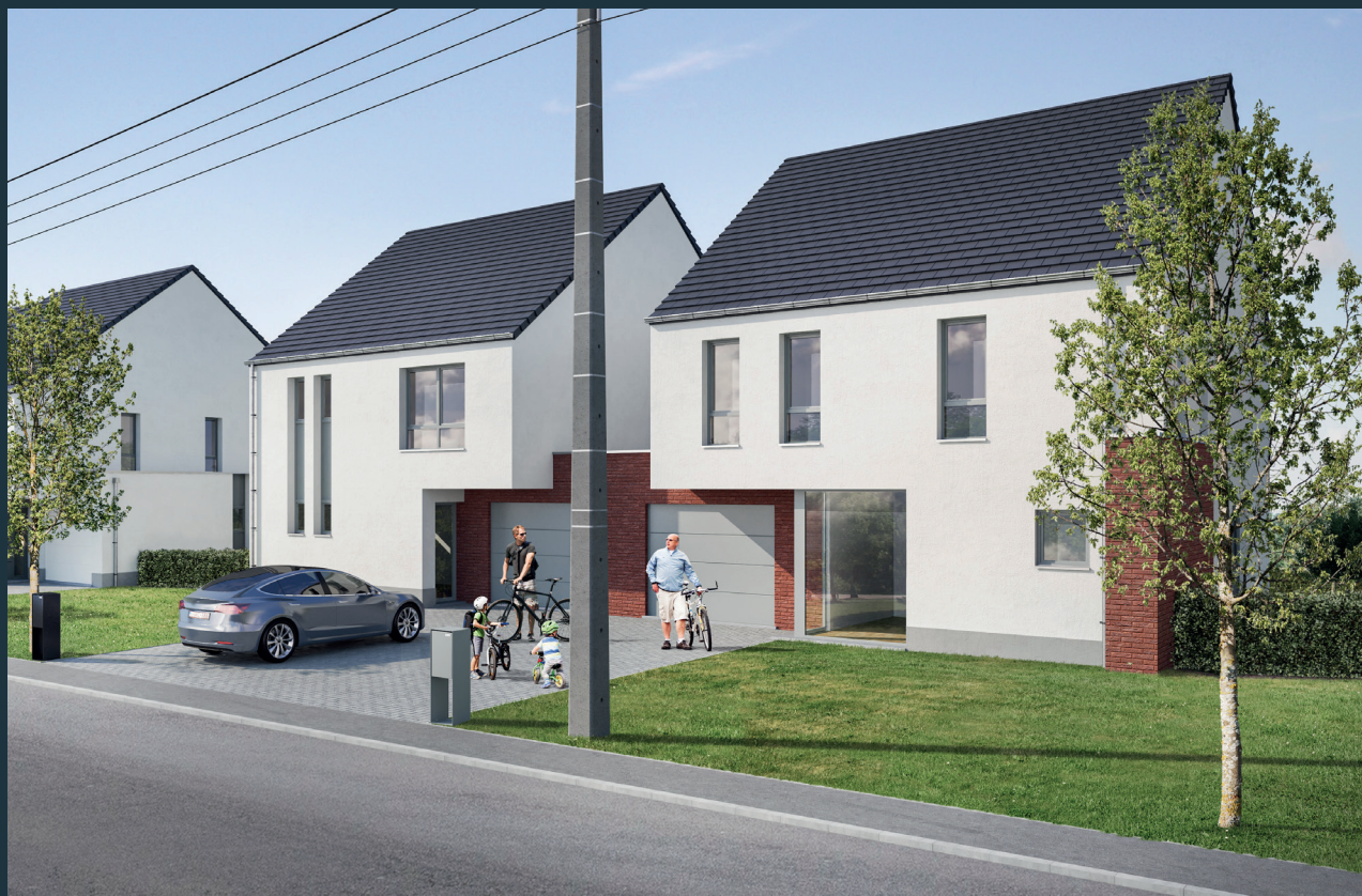
Simulation 3D des maisons 4 et 5 (vue piétonne depuis la rue)
